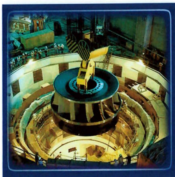
Fig.3.10 - Rotor Francis de Itaipu
